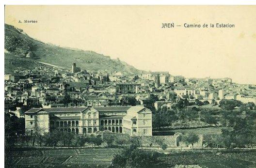
Paseo de Alfonso XIII al paso del Asilo de las Hermanitas de los Pobres de San José
