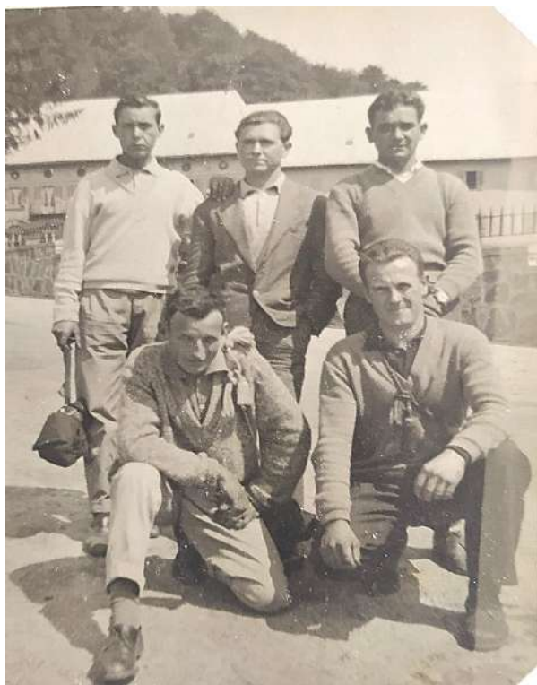
Foto 10: De izquierda a derecha, fila de arriba: Antonio Moreno (Pachopín), Fernando Gasco (Caramelo), Francisco Lanzas (Caracol). Los de la fila de abajo son mozos de la zona. Estaban trabajando construyendo un carretil de Azparren a Oroz Betelu. En la foto, de visita a Roncesvalles. Año 1961.
